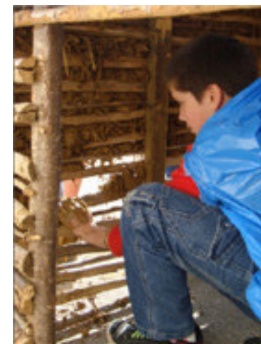
CONSTRUCTION EN COURS
