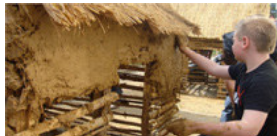
CONSTRUCTION EN COURS
